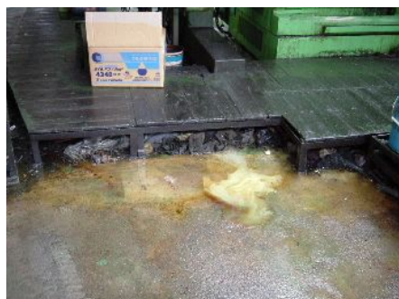
測定器以外(作業場)の汚れの改善
