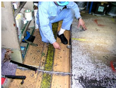
日常点検の様子
